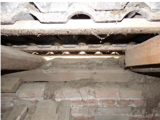
**Abb. 35 Spalte am Dachüberstand von Gebäude 2.**
