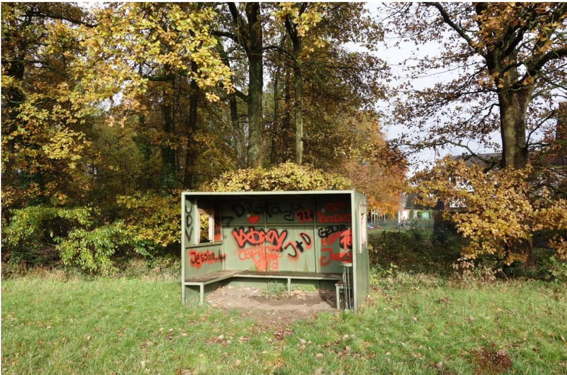
Schutzhütte bestehend aus Stahlplatten ohne Spaltenverstecke
