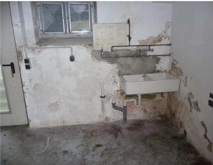
Abbildung 18: Feuchtigkeitsschäden Kellergeschoss
