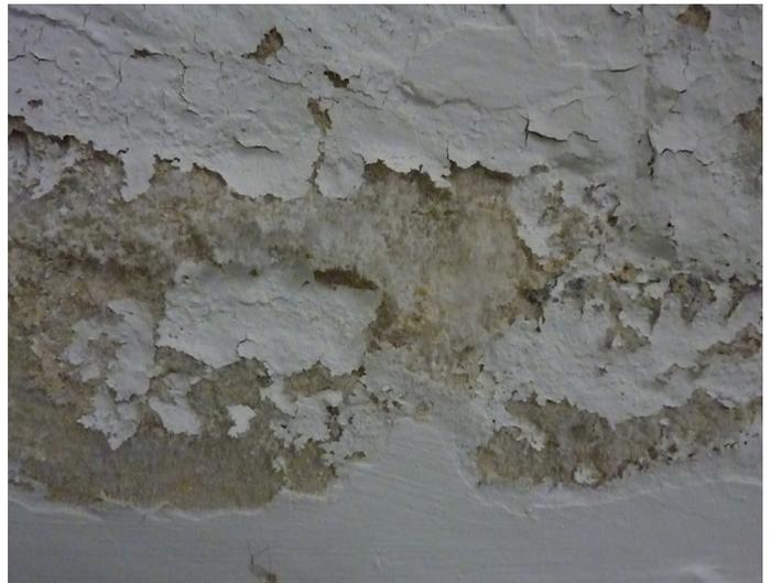
Abbildung 19: Feuchtigkeitsschäden Gebäudetrennwand Kellergeschoss
