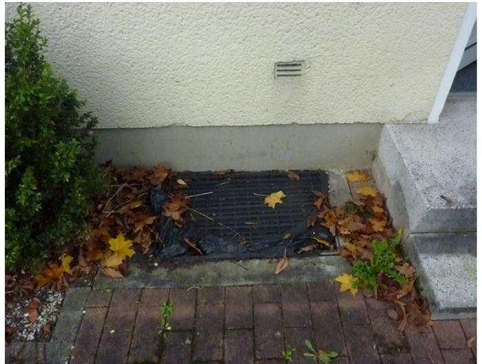
Abbildung 21: Provisorisch abgedeckte Lichtschächte
