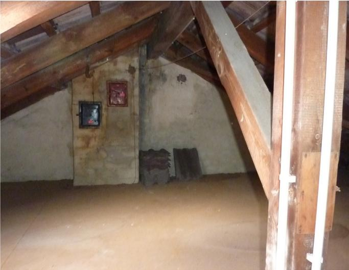
Abbildung 16: Feuchtigkeitsschäden Dachgeschoss
