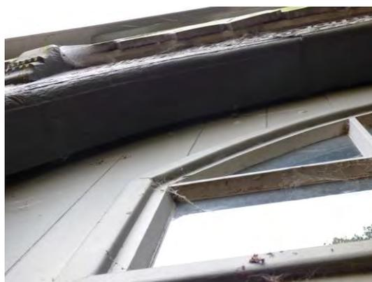
**Abb. 49 Spalte hinter dem Bogen über dem Dielentor.**
