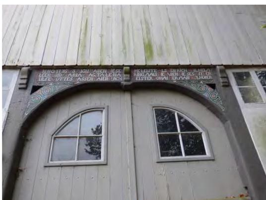
**Abb. 48 Bogen über dem Dielentor mit dahinter liegenden Spalten.**
