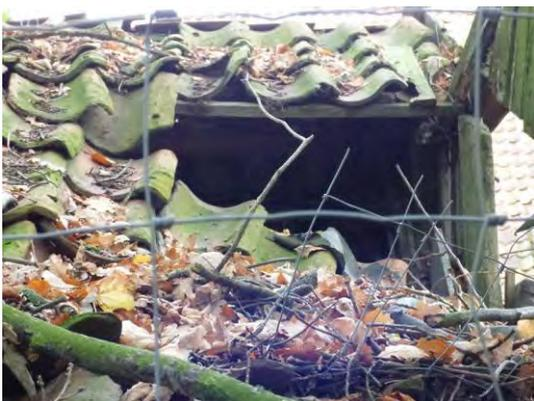
**Abb. 106** Defektes Dach des zweiten Nebengebäudes.
