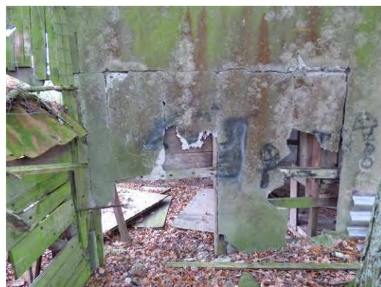
**Abb. 99 Spalte zwischen Brettern und Spanplatte.**
