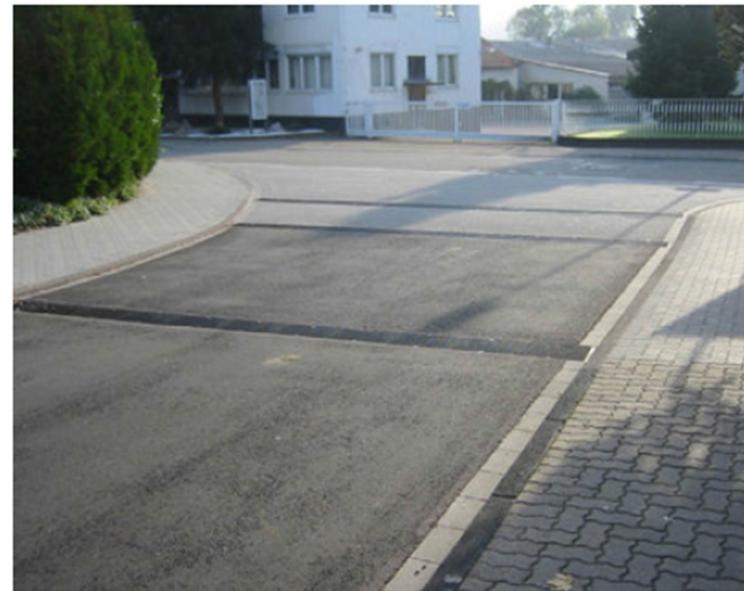
Bild 17: Straßeneinläufe und Querrinne zur Wasseraufnahme bei hohem Längsgefälle
