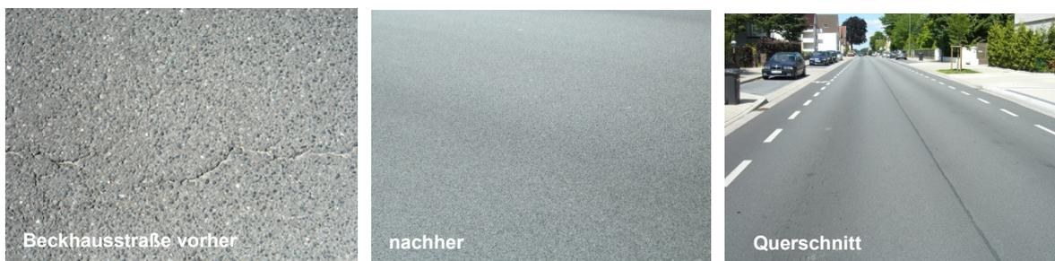
**Abb. 17: Lärmarme Fahrbahnbeläge**
