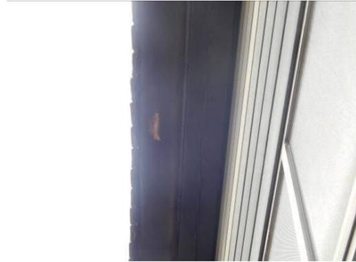
Abb. 62 Spalten zwischen Balken über dem Tor von Gebäude 8.
