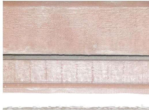
Abb. 34 Spalten zwischen Balken des Dachüberstandes von Gebäude 3.
