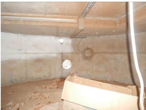
Abb. 43 Innenansicht des unteren Teils des Spänebunkers mit Kernbohrungen.
