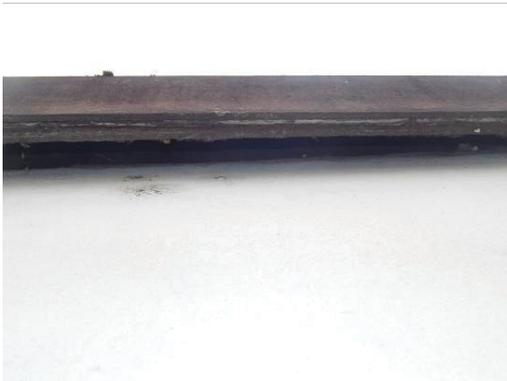
Abb. 50 Spalte hinter Holzverkleidung des Giebels von Gebäude 6.
