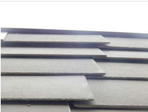
Abb. 76 Spalten hinter Schindeln und Metallverkleidung an Gebäude 11.
