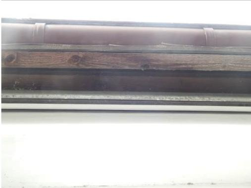
Abb. 48 Spalte zwischen zwei Balken am Dachüberstand von Gebäude 6.
