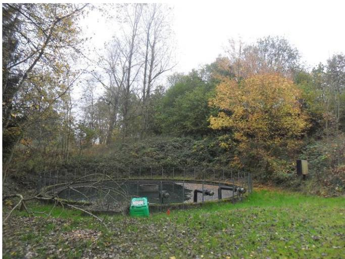
**Abb. 43**    Kreisförmiges Klärwasserbecken.
