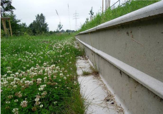
**Beispiel eines Leitelementes mit Lauffläche und doppeltem Überkletterungsschutz (Leitelement der Fa. ACO PRO, eingebaut in Hamm)**
