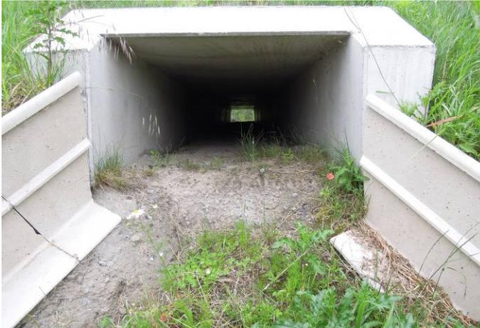
**Beispiel eines ACO PRO-Stelztunnels mit Lauffläche aus anstehendem Boden in Hamm**
