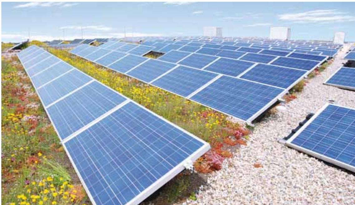
Beispiel einer Dachbegrünung mit Photovoltaikmodulen (Quelle: OPTIGRÜN 2010)
