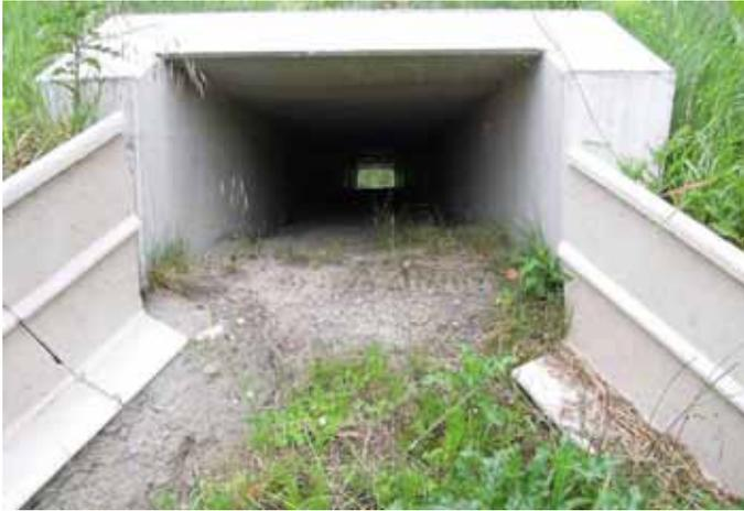
**Beispiel eines ACO PRO-Stelztunnels mit Lauffläche aus anstehendem Boden in Hamm**
