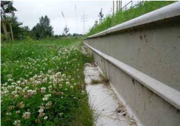
**ACO PRO Leitelement mit Lauffläche und doppeltem Überkletterungsschutz**
