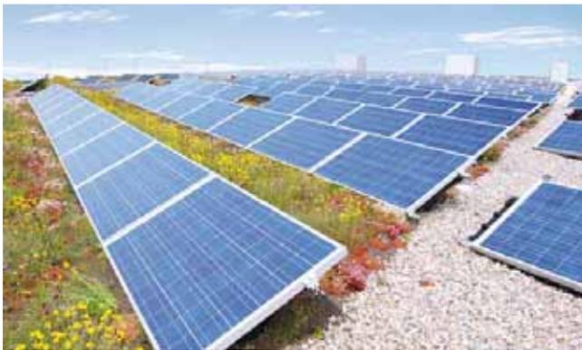
„Kombination mit Zukunft“: Bei der Kombination von Photovoltaikanlage mit Gründach lässt sich aufgrund der Kühlung der Module die Rentabilität der Photovoltaikanlagen steigern (OPTIGRÜN 2010)
