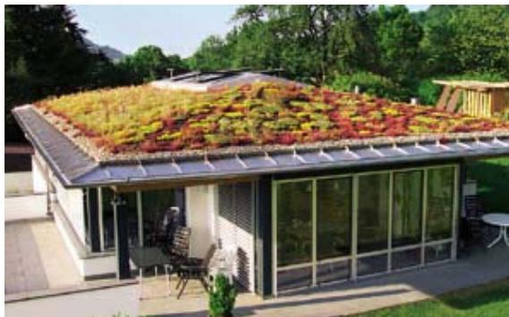
**Abb. 8: Extensive Flach- und Schrägdachbegrünung** (Quelle: [www.optigruen.de](http://www.optigruen.de))
