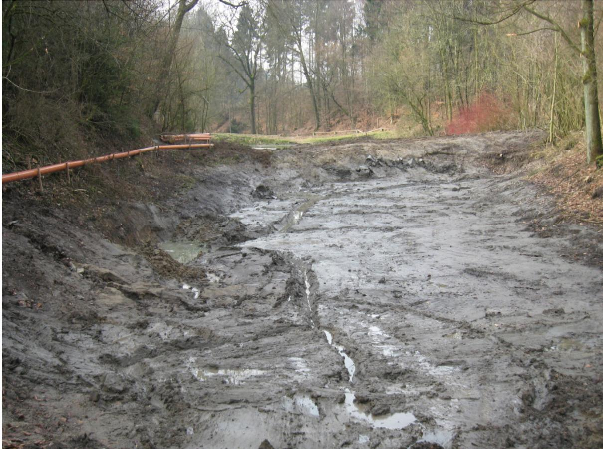
Teich 1 nach Trockenlegung und Auskoffnung des Faulschlammms
