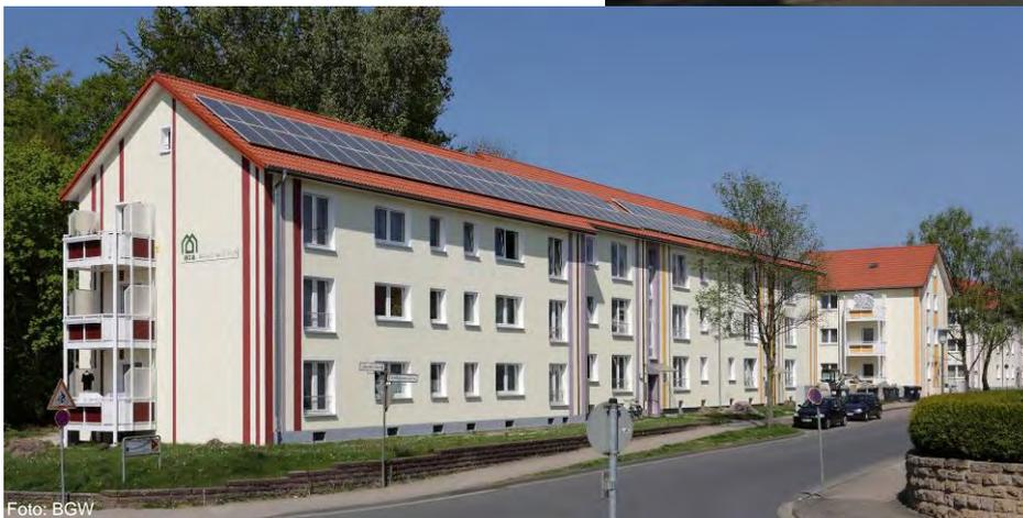
Der Gebäudekomplex wird 2008 umfassend saniert. Die Gebäude werden mit neuen Dächern versehen, Fassaden, Kellerdecken und Dachböden erhalten eine Wärmedämmung. Haustüren, Kellerfenster und -türen und sämtliche Fenster werden erneuert und entsprechen jetzt aktuellen Dämmstandards. Insgesamt werden die Grenzwerte der 2008 gültigen EnEV 2007 um 30 % unterschritten. Die Kosten der gesamten Sanierungsmaßnahme liegen bei rd. 640.000 € bzw. 630 €/m<sup>2</sup>.
